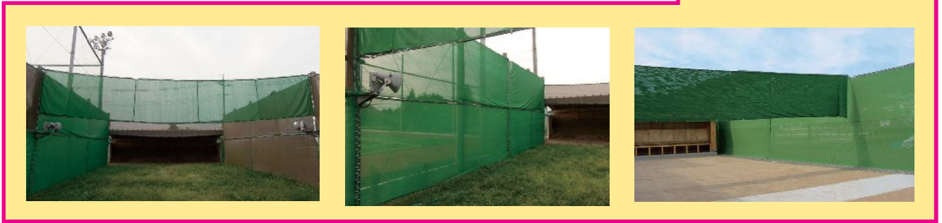
施工参考写真 防矢ネット
